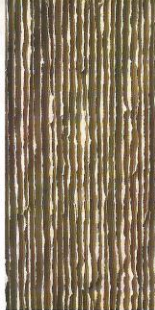
Oben: Lackfläche mit aufrecht stehenden, gerissenen Papierstreifen, rechts Putz mit blauer Lasur und stellenweiser Versilberung (Ausführung: Achim Gieske).
